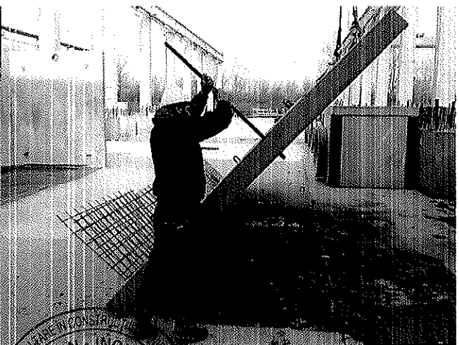
Fig.3 Pregătirea elementelor pentru îmbinare și fixarea acestora
